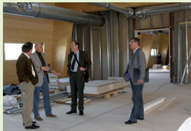
Gerhard Huber, Erhard Bojanovsky, Claudius Kollmann und Wolfgang Hutter besichtigen den Baufortschritt (v. li.)
