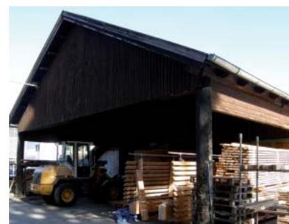
Die 36,5 m lange Halle weist ein Vordach mit 8 m auf
