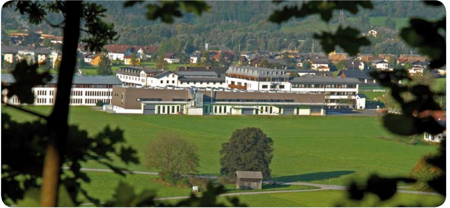
Trapezförmige Leimbinderkonstruktion - die 97 m lange Halle fügt sich harmonisch in die Kuchler Umgebung ein
