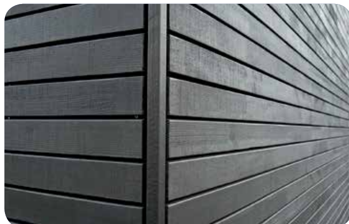
Die Fassade besteht aus grau beschichteten Rhombusprofilen aus Tannenholz (FASZINO®)
