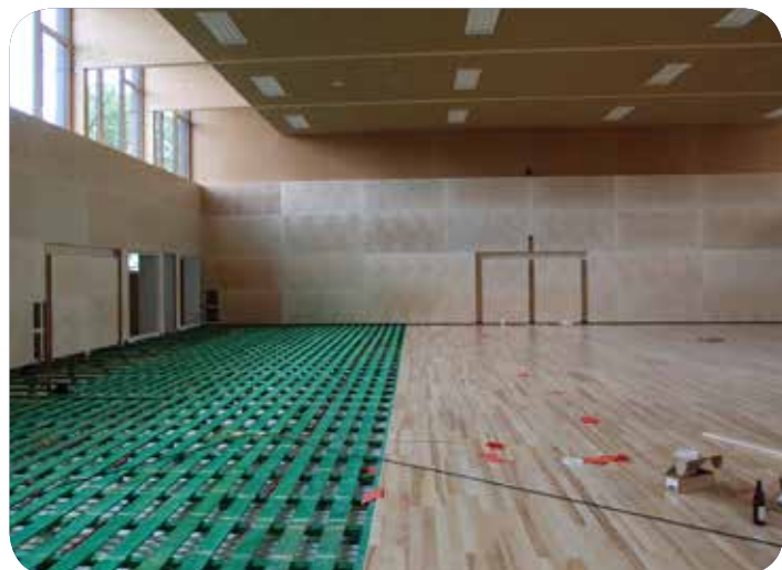
Montage des Parkettbodens
