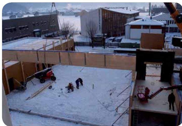
Leimbinderkonstruktion für die neue Turnhalle
