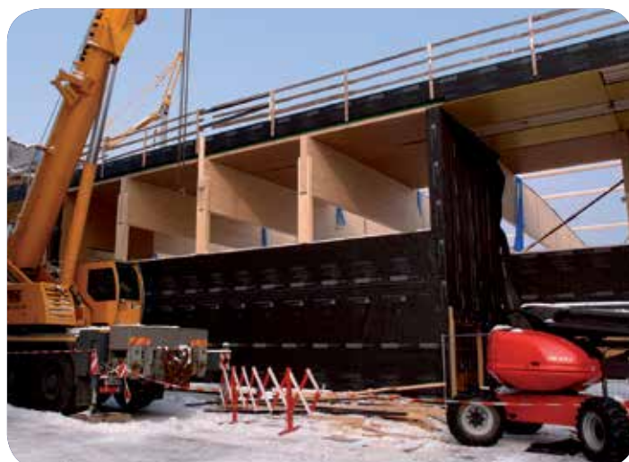
Dachelemente wurden mit einem Kran eingehoben
