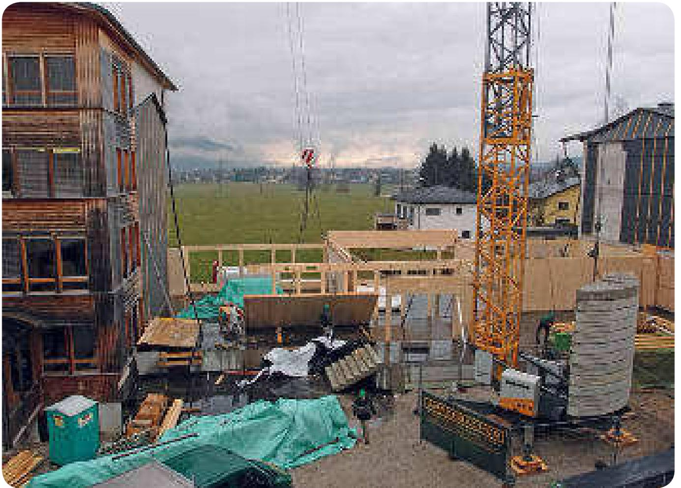
*Aufstellung der vorgefertigten Brettsperrholzwände im Erdgeschoss*
