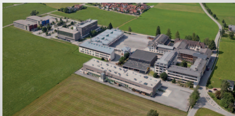
Das Areal des Holztechnikums Kuchl – 9,8 Mio. Euro investieren Holzindustrie, Land Salzburg und Bund in eine moderne Infrastruktur, im Sommer erfolgte der Spatenstich für den Schulneubau
