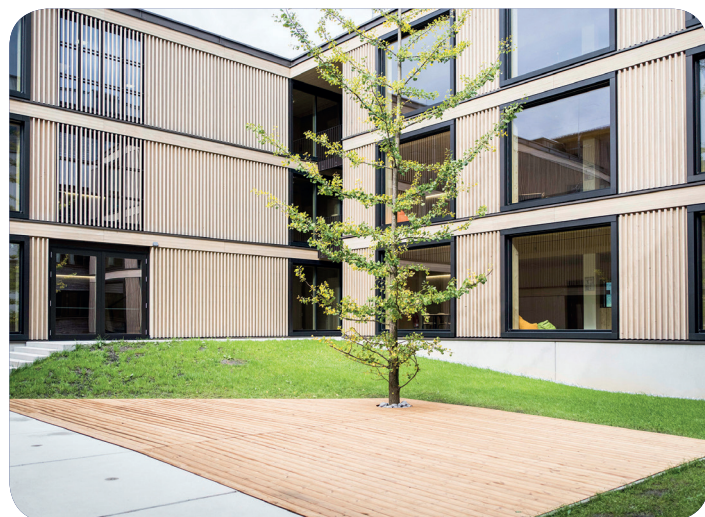
660 m 3 Brettspertholz und 86 m 3 Brettschichtholz wurden insgesamt verbaut - Blick in den neuen Innenhof
