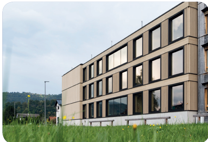
Der erste Bauteil wurde komplett abgerissen und wieder neu errichtet - Baubeginn war Juli 2015 und die zweite Bauetappe (Generalsanierung) konnte im Frühjahr 2017 abgeschlossen werden
