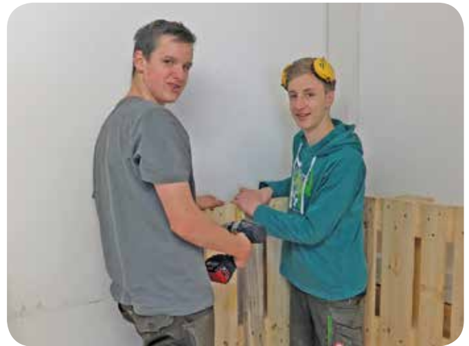
Die Rückwand entsteht
