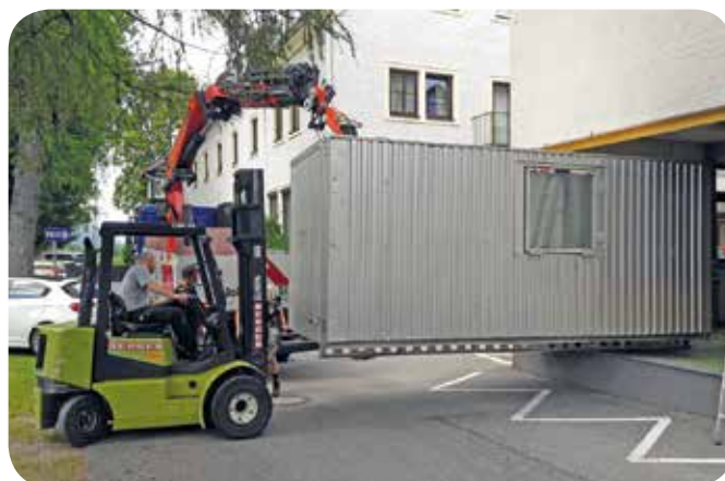
Aufstellung der neuen Trockenkammer
