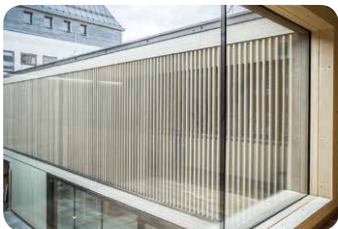
Blick auf die Außenfassade im Innenhof
