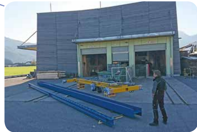
Herbert Irrnberger bereitet nach der Anlieferung die Montage des Deckenkranes vor
