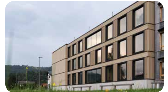
Die ansprechende, sägeraue Tannenfassade
