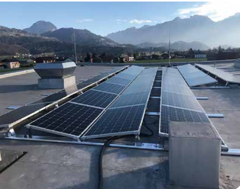
Positioniert am Dach der Turnhalle
