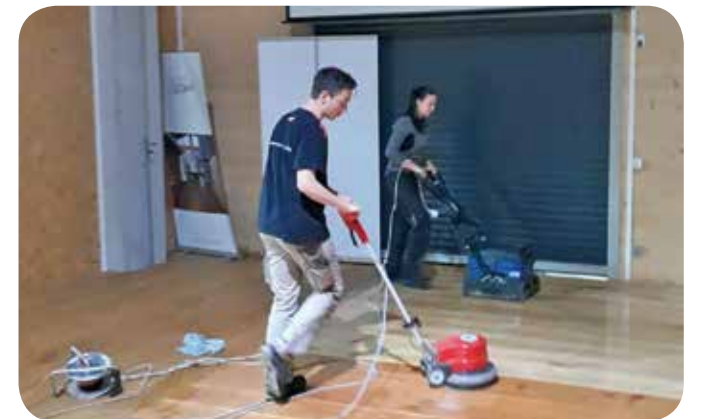
Beim Verlegen und Reinigen von Holzböden
