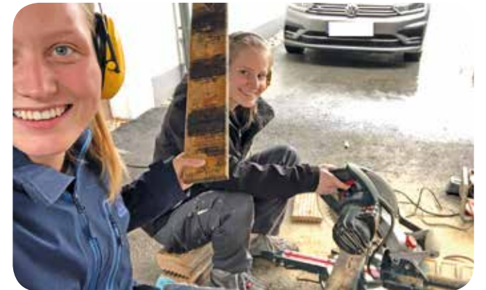
Beim Bau einer Holzterrasse
