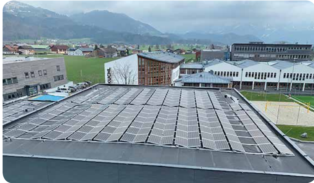
Klimaschonende Stromerzeugung - 150 KWp liefern nachhaltig Strom
