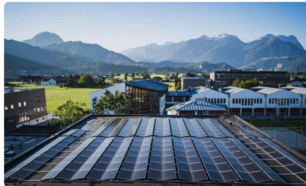
Eine PV-Anlage (150 KWpeak) wurde im Zuge des Schulneubaus installiert
