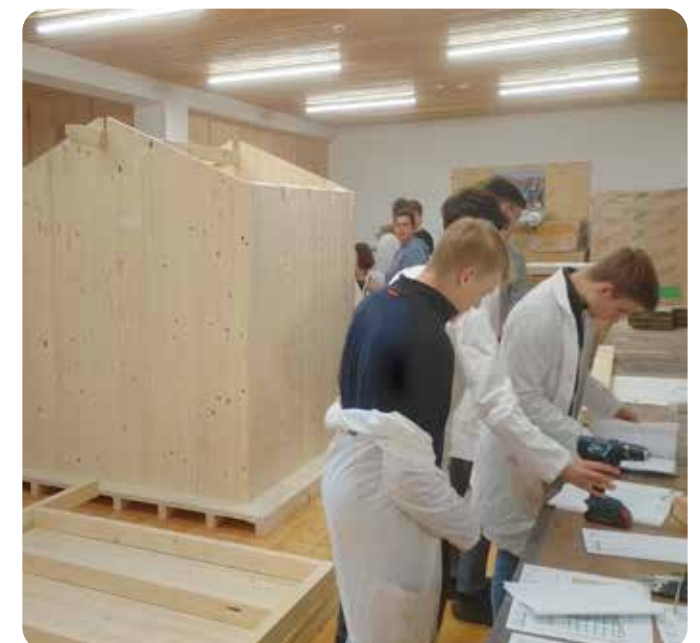
Errichtung der Multi Häuser im Holzbau-Labor
